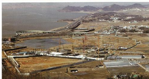
2011년 2단계 기반시설 조성공사
